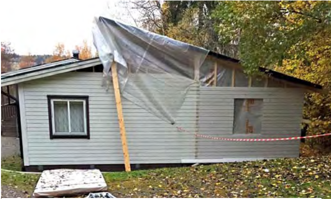
24 okt - Plasten ska hindra regnet
