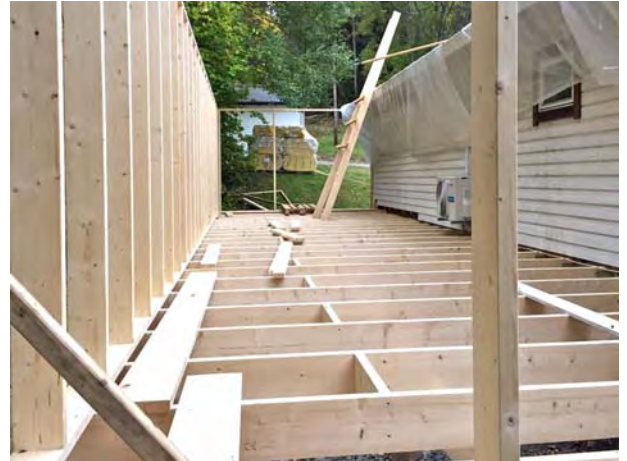
12 okt - Väggen på gång
